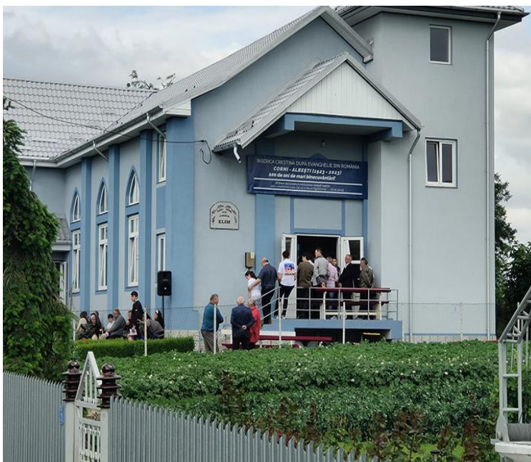
Biserica Creștină după Evanghelie „Elim” din satul Corni, la sărbătoarea centenarului 2023 (1922-2022), clădirea a fost recondiționată în anul 2022
